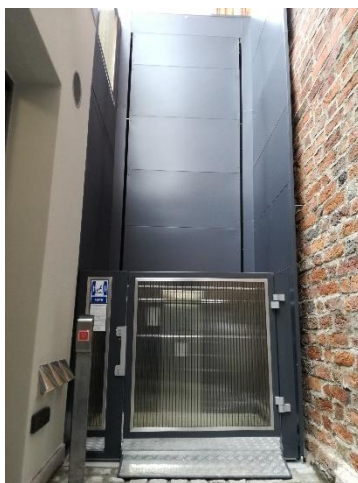
Rys. 4 platforma transportu pionowego dla osób niepełnosprawnych [3]
