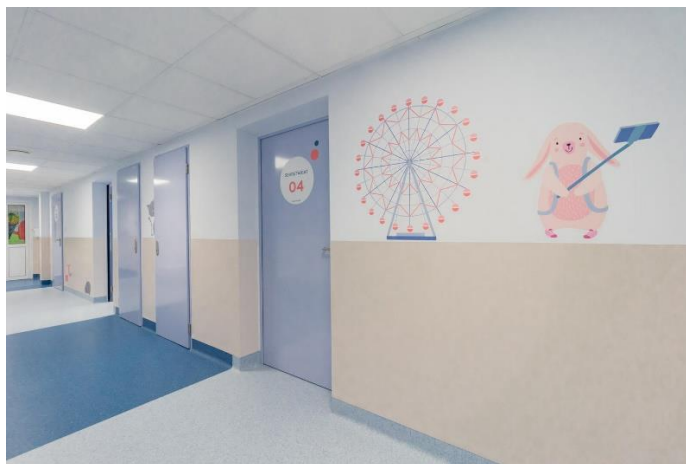
Rys. 15 Zabezpieczenia ścian z wykładzin homogenicznych [12]
